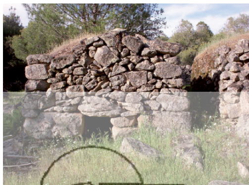
Fig. 20. Muro en talud de la zahúrda
