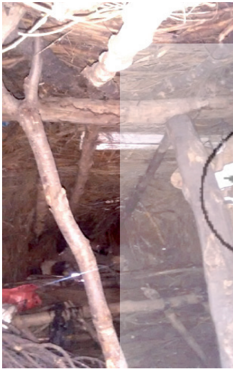
Fig. 27. Entramado de soportes de la choza
