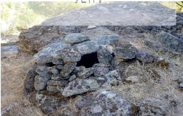
Fig. 34. Derrumbe de una zahúrda de La Adrada
