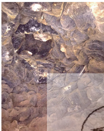
Fig 9. Vista interna de la cúpula falsa de la zahúrda de Fuente Menga
